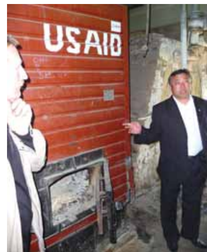
Благодаря новому котлу в сельской школе станет теплее
